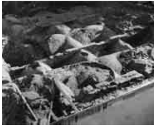
46 Kiel, Alter Markt: Blick auf die Kellergewölbe des Alten Rathauses mit zum Teil eingeschlagenen Gewölbekappen, Foto 25. Febr. 1971.
