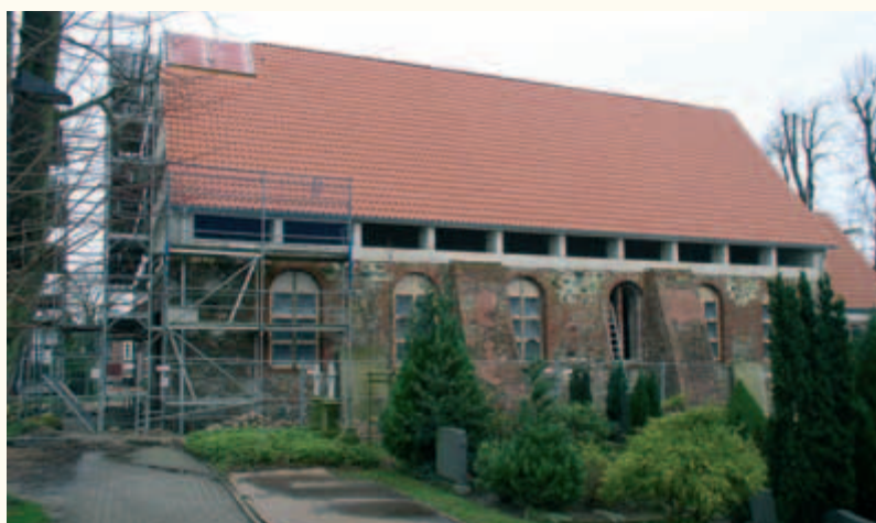
Blick von Süden während des Wiederaufbaus.
