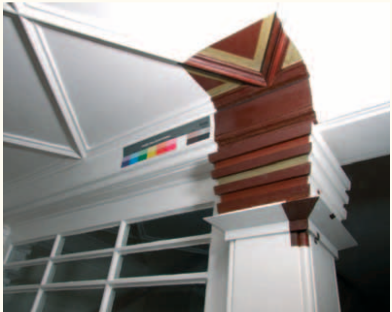
Das Freilegungsfenster zeigt, wie die originale Mehrfarbigkeit die feingliedrige Architektur differenziert, hier am Deckenanschluss zum Vorraum.
