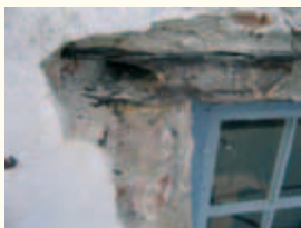
Schäden im Fenstersturz- bereich.
