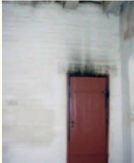
Durch sämtliche Ritzen ist Ruß in den „Gotischen Saal“ eingedrungen. Die große Hitzeeinwirkung verursachte Verfärbungen des Deckenanstrichs.
