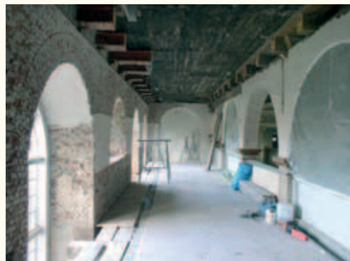
Nördliche Empore mit abgetrennten Deckenbalken.
