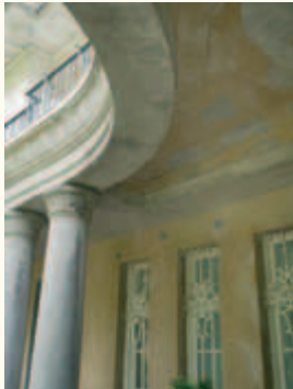
Vorhalle im Bauzustand, Deckendetail.
