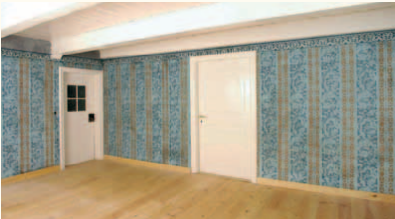
Schablonenmalerei nach der Wiederherstellung.
