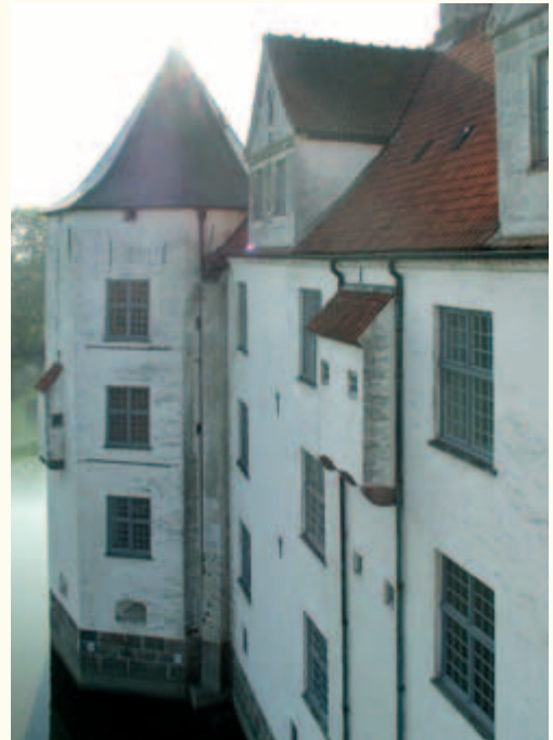
Nordfassade vor der Sanierung.
