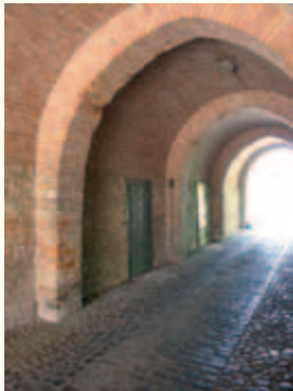
Tordurchfahrt nach der Mauerwerksanierung.
