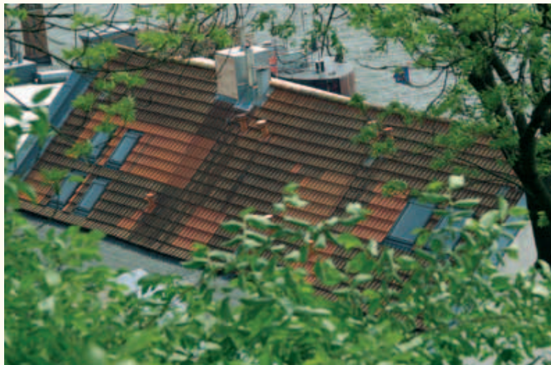
Heutiger Zustand eines Daches mit rückgebauten Dachflächenfenstern.
