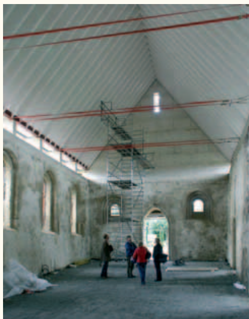
Blick in das Kirchenschiff nach Westen vor Einbau der Emporen.
