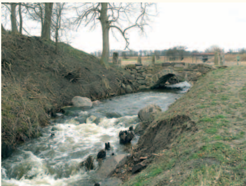
Bogenbrücke in Löhrstorf.
