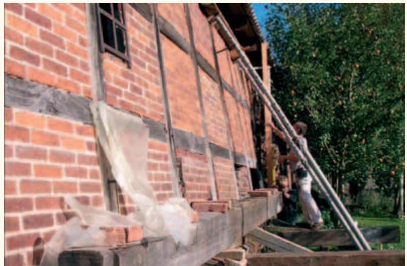
Erneuerung einer Fachwerk- wand.
