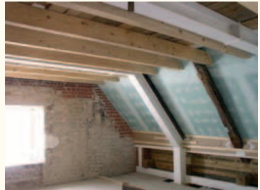
Blick in den gesicherten Dachstuhl.
