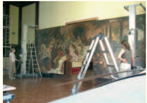
Das Gemälde wird mit Liften erschütterungsfrei aus der Vertäfelung gehoben und abgesenkt.
