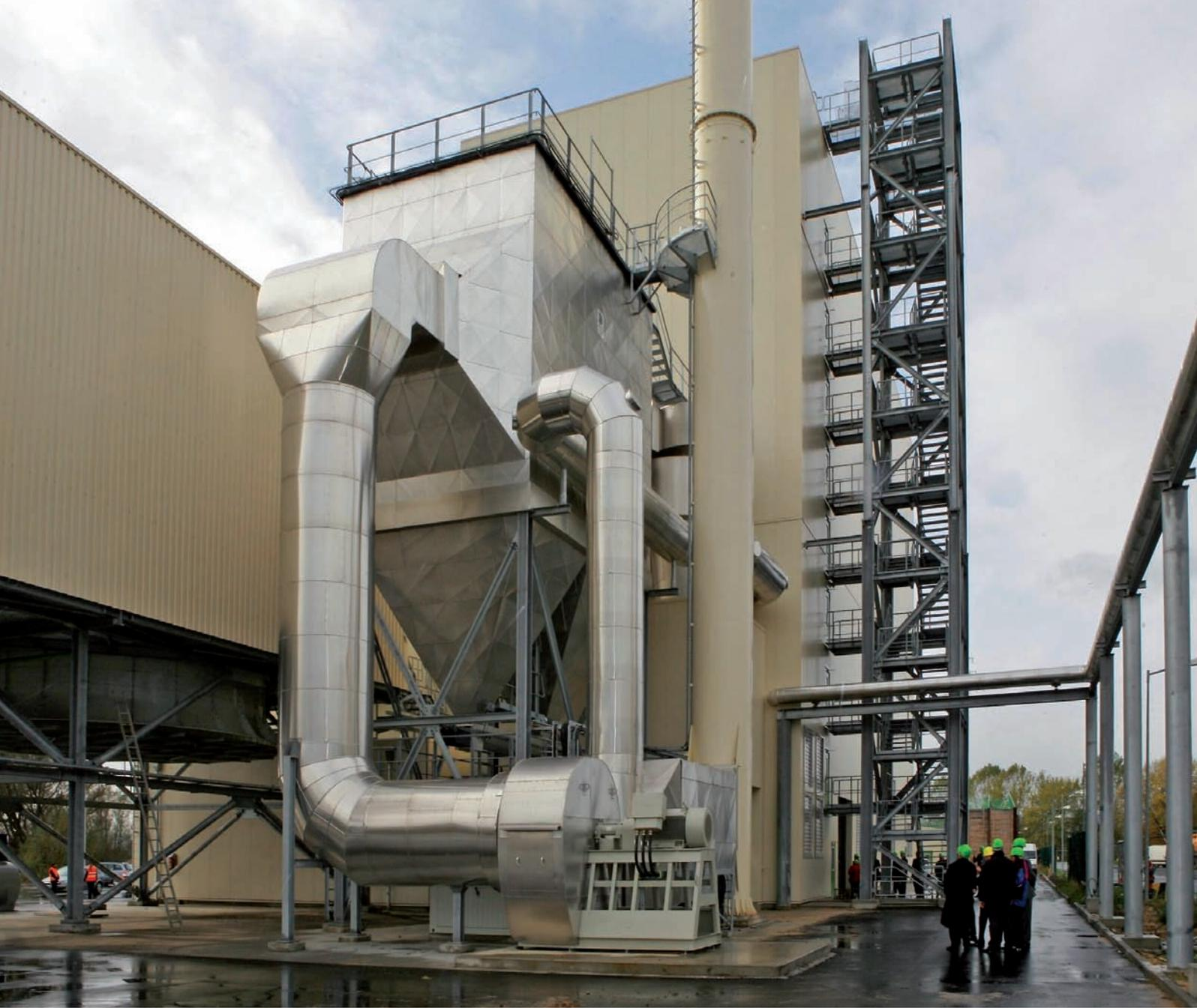
Im Biomasse-Heizkraftwerk Brunsbüttel wird durch das Verbrennen von Knick- und Baumschnitt Dampf als Wärmeenergie für die benachbarte Industrie und Strom erzeugt.
